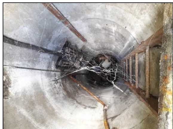
Intérieur du forage
