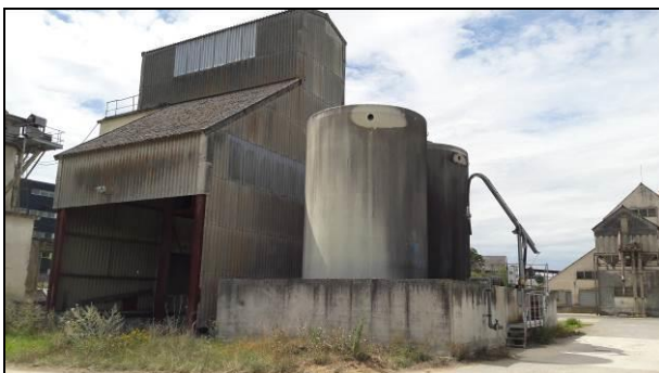
Entrepôts (azote liquide) et bureaux (bâtiment 4)
