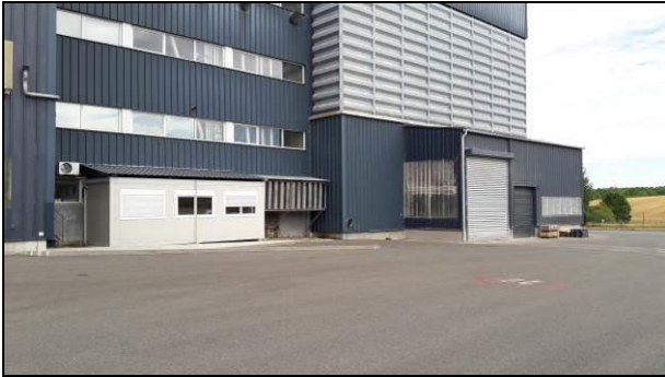
Partie sud – Assainissement sous voirie (non visible)
