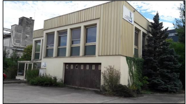
Anciens laboratoires (bâtiment 5)
