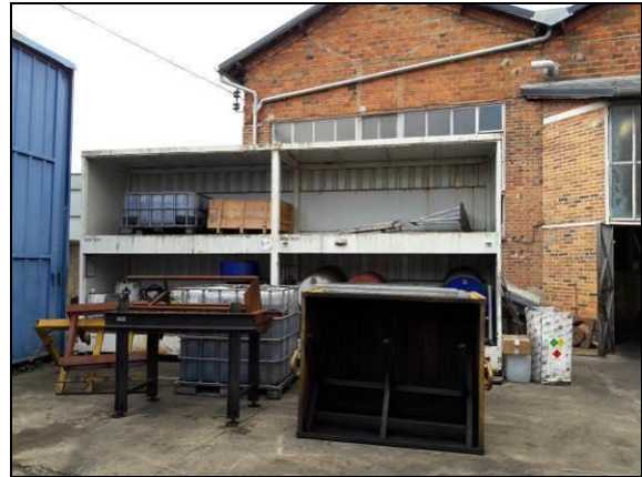
Stockage des huiles sur rétention
