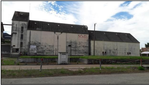
Entrepôts de la SCAEL (bâtiment 1)
