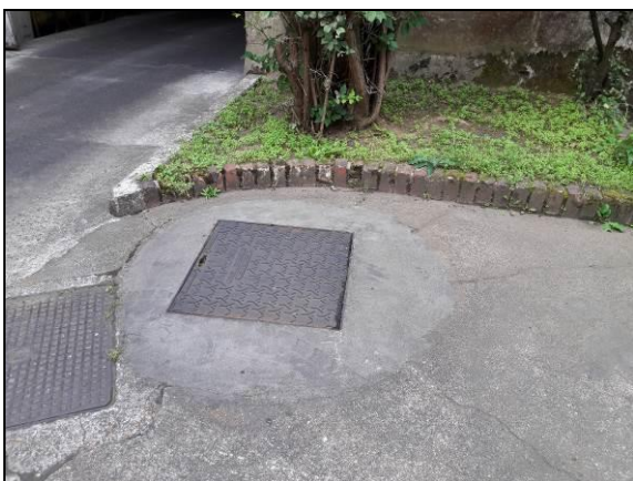
Forage du site
