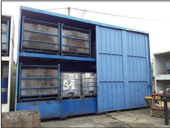
Stockage des huiles sur rétention
